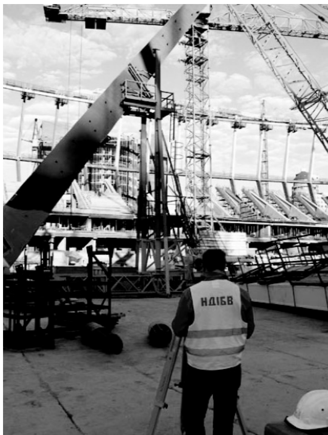
Рис. 4 Проведення геодезичних робіт при складанні колони
