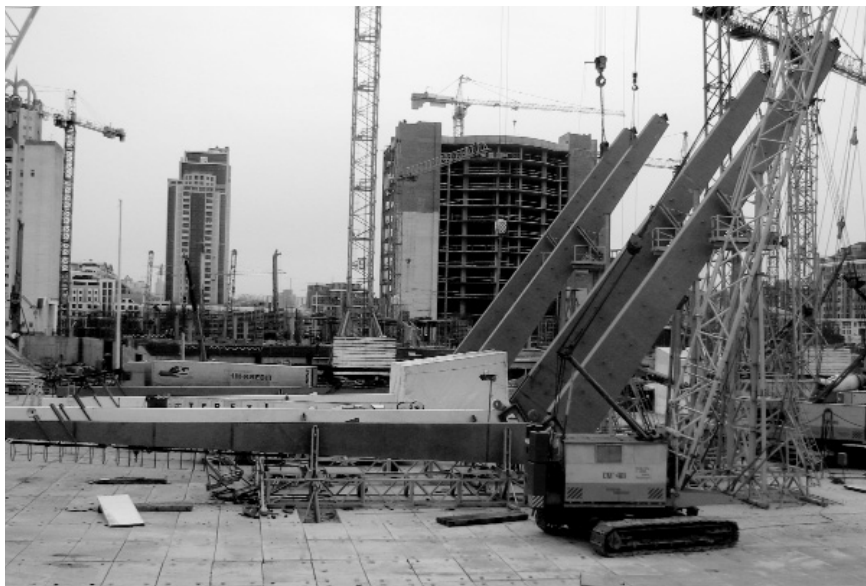
Рис. 1. Загальний вигляд розміщення колон на стенді
