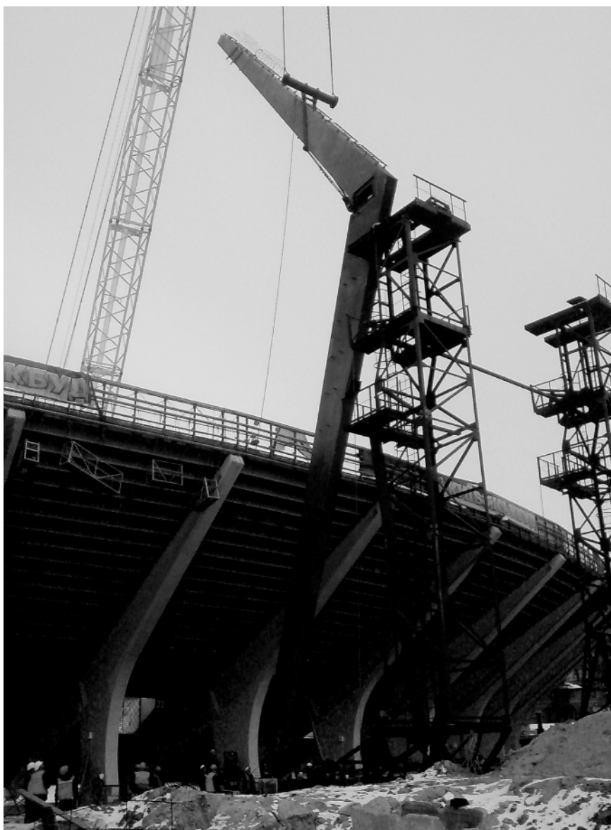
Рис. 2. Загальний вигляд монтажу колони
